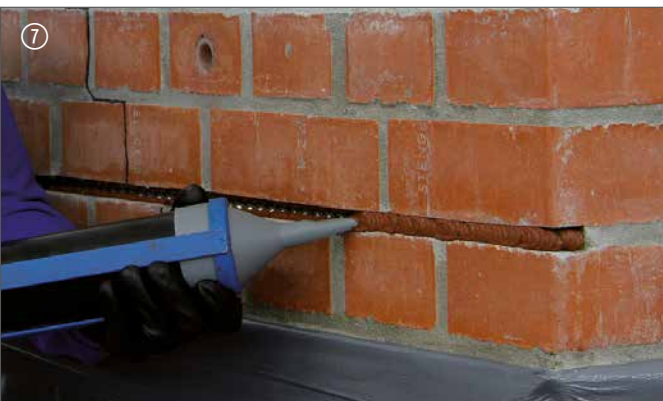
Zweite Lage DESOI Spiralankermörtel einbringen Insert second layer of DESOI Spiral Anchor Mortar
