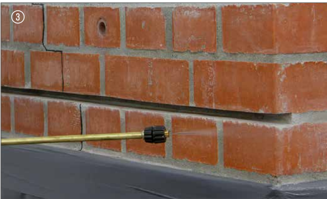
Fuge vornässen | Wet the joint / slot
