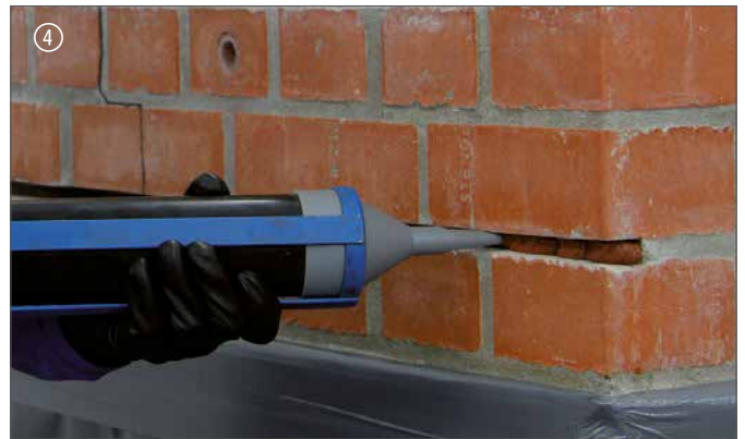
Erste Lage DESOI Spiralankermörtel einbringen | Insert first layer of DESOI Spiral Anchor Mortar
