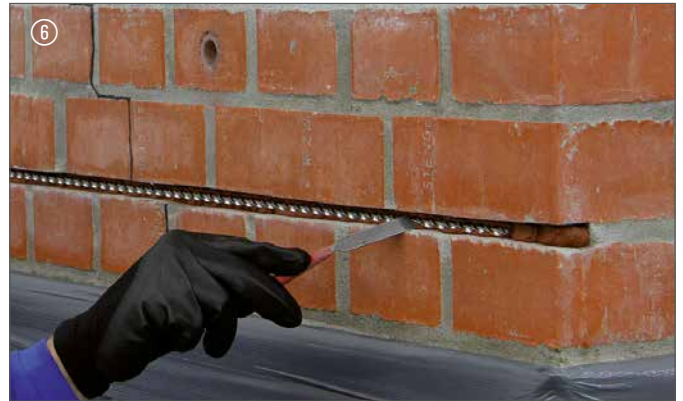
DESOI Spiralanker in den Spiralankermörtel drücken | Embed the DESOI Spiral Anchor Mortar
